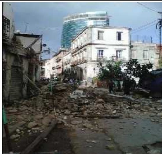
Fig.5: Effondrements d'un bâtiment dans la médina (24)
